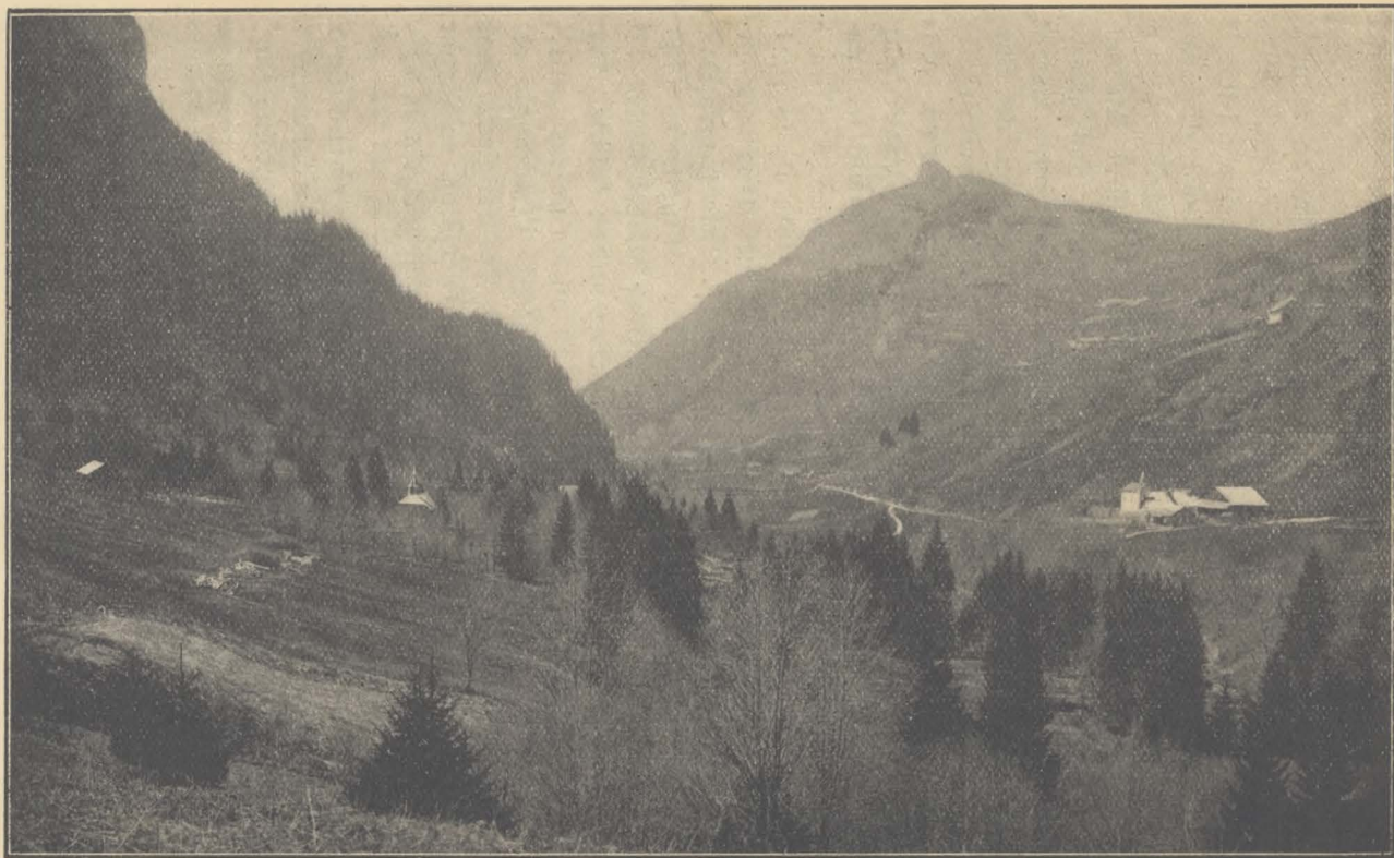
Vue d'ensemble. — A droite : Génicot l'Abbaye); à gauche : La Chèvre (Photo Fr. Tornier)
